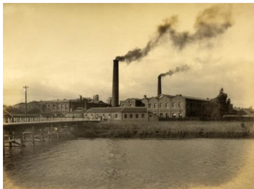
大正初期の尼崎紡績。近世以降の古い家屋の中にレンガ造りの近代工場が出現した。
